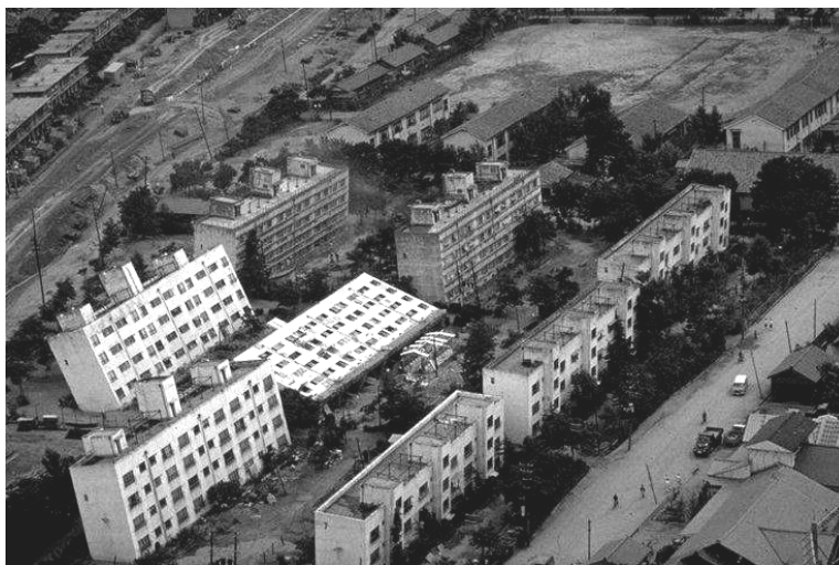
Figura 1.4 - Edificios inclinados por licuación de arenas
